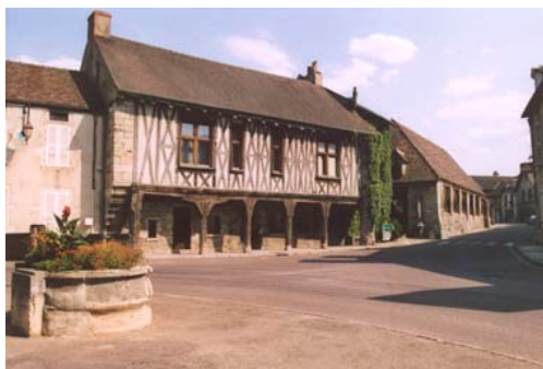
La maison du Receveur à Vitteaux (FR) - 14 e siècle -
